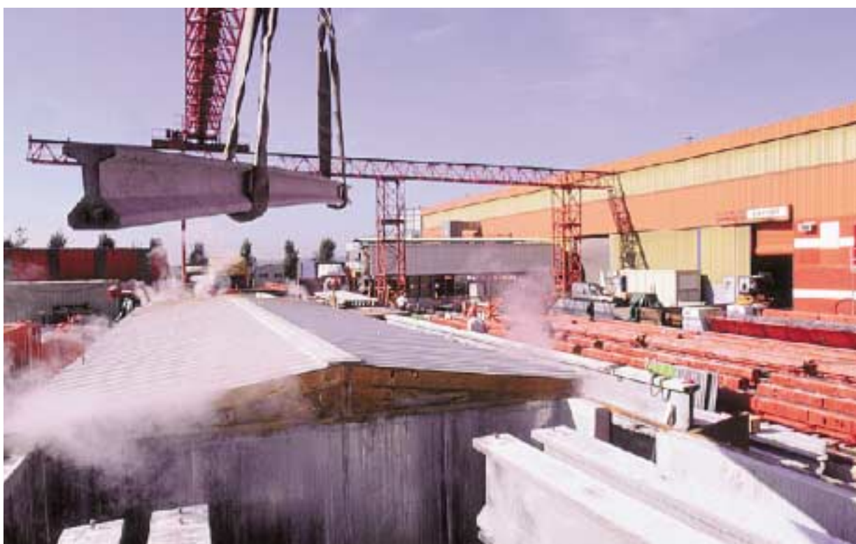
Préfabrication des poutres précontraintes pour l'aéroréfrigérant de la centrale de Cattenom.
