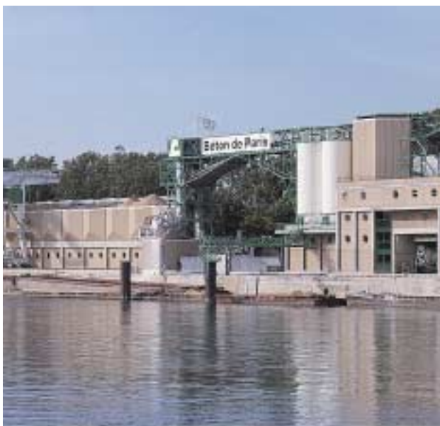
Centrale à béton.
