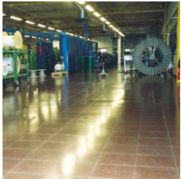
Les dalles en béton sont bien adaptées aux sols industriels.
