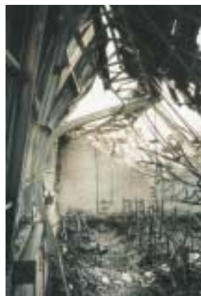
Le mur coupe-feu en blocs de béton 20x20x50, CF 4 h a parfaitement rempli sa mission. Le feu a été contenu dans ses limites
