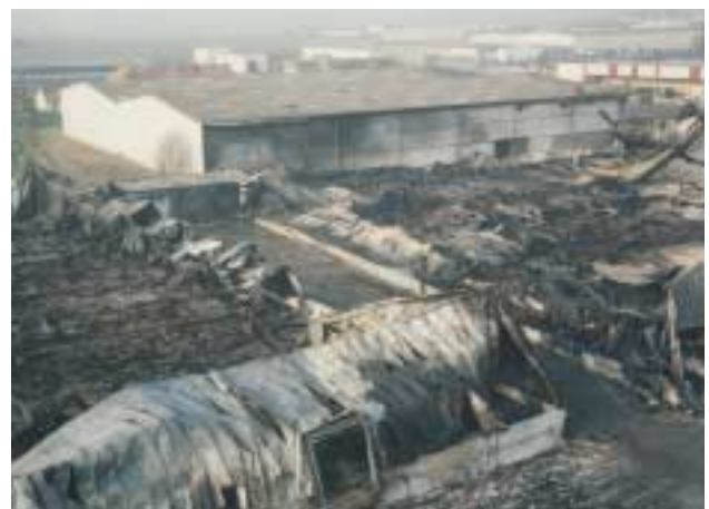
Un bâtiment a été sauvé grâce au mur coupe-feu en blocs de béton.
