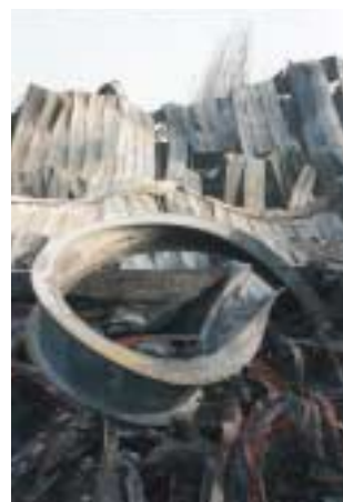
La propagation du feu a été possible. Elle s'est faite par rayonnement et transport des gaz chauds
