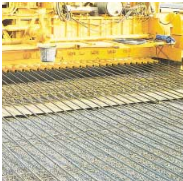
Béton armé continu : armatures en fer rond ou en ruban cranté.
