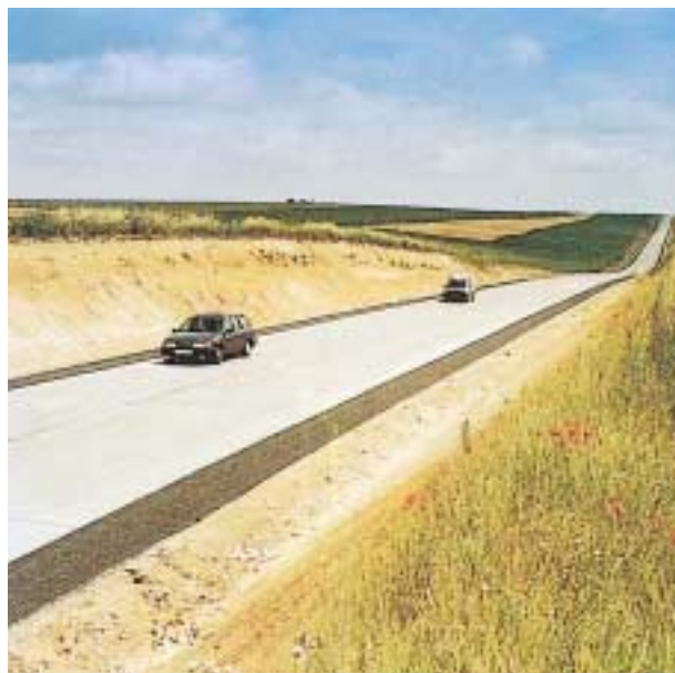
Chaussée épaisse en dalles courtes non armées.
