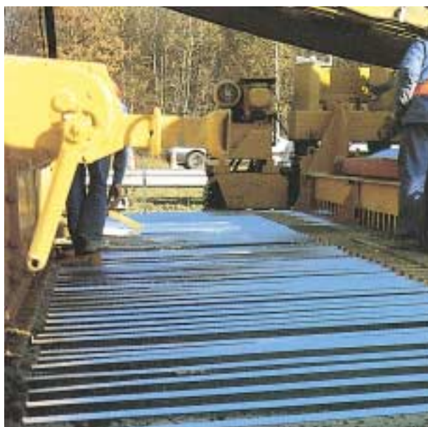
Béton armé continu : armatures en fer rond ou en ruban cranté.
