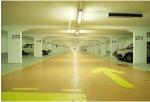
L'un des cas les plus courants d'utilisation des poutres précontraintes : les parkings.
