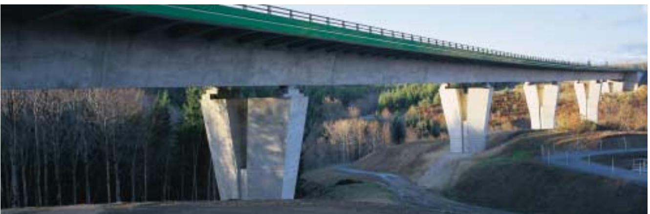
Viaduc des Bergères.
