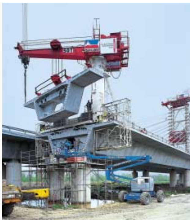
Viaduc des Barrails.
