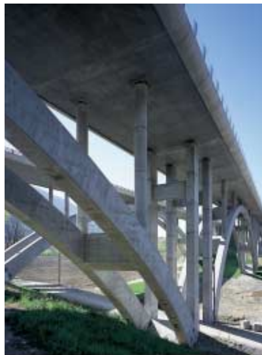
Viaduc du Crozet (A 51).
