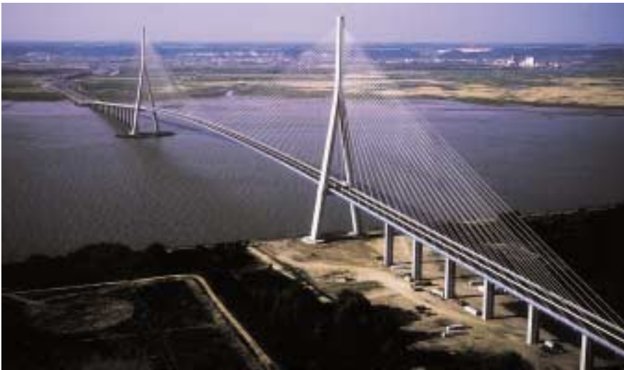
Pont de Normandie.
