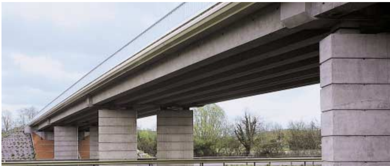
Pont de la Pyrénéenne (A 64).
