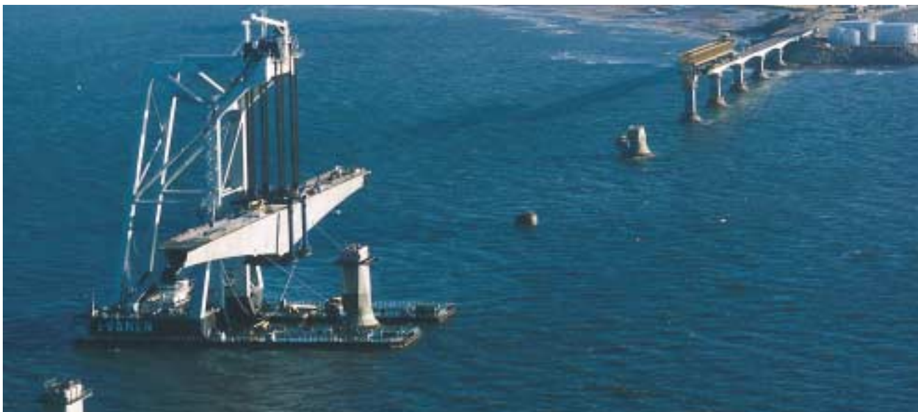
Pont de la Confédération.
