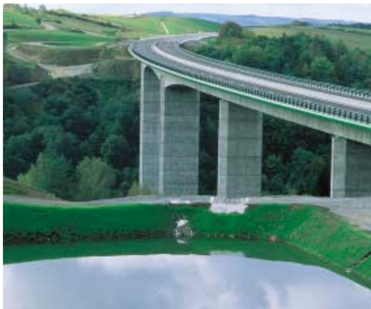
Viaduc de la Clidane (A 89).
