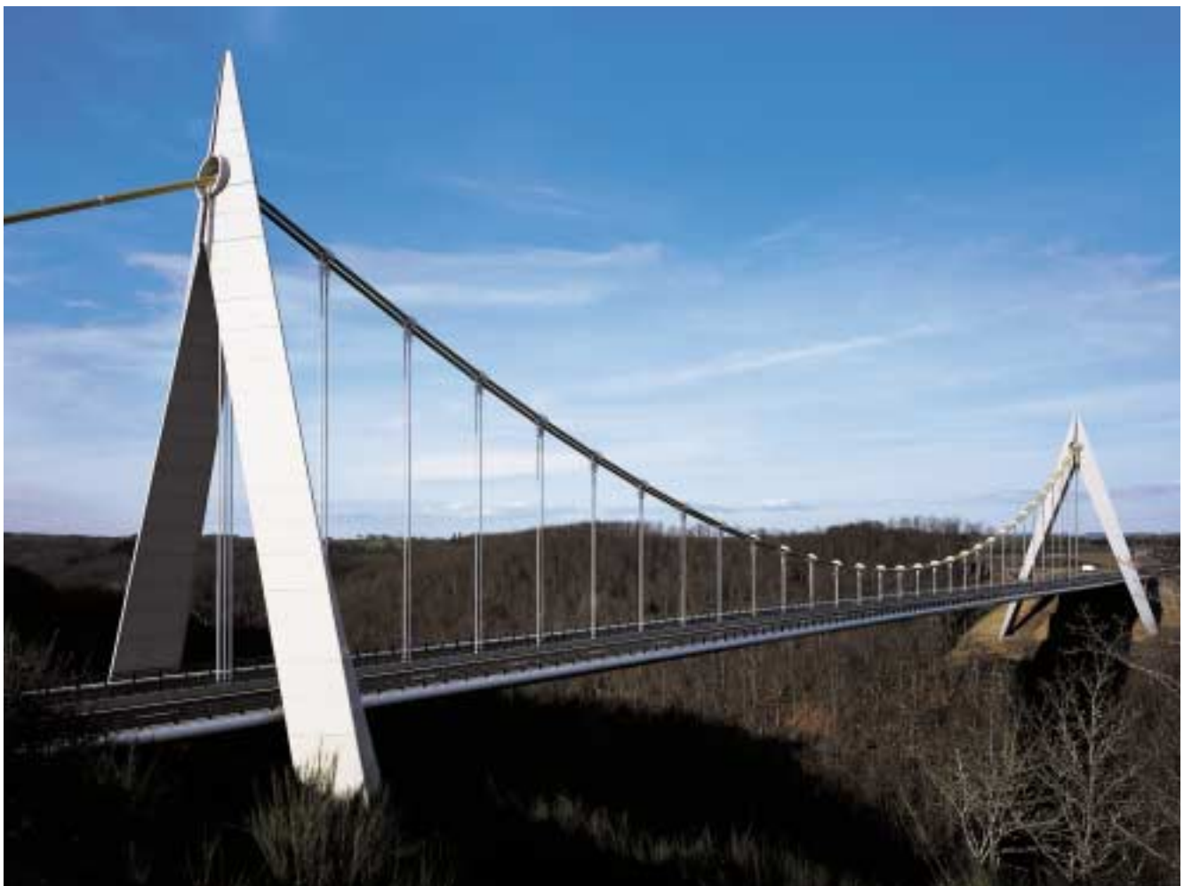
Viaduc du Chavanon.
