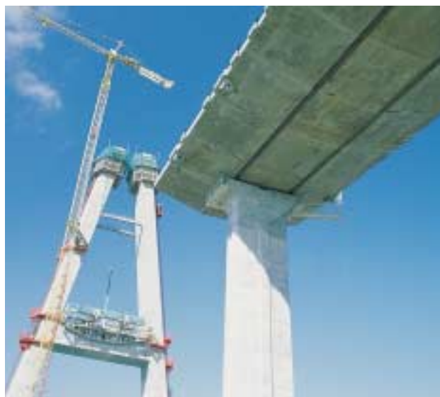
Pont de Normandie en construction.
