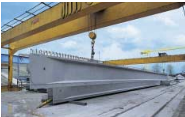
Poutres préfabriquées précontraintes.
