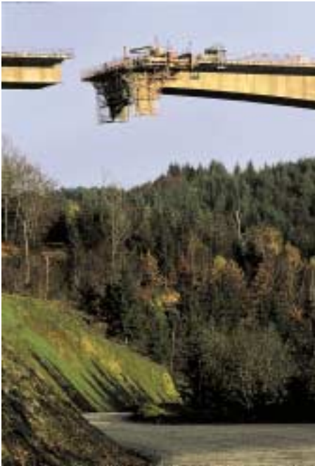
Construction en encorbellement.
