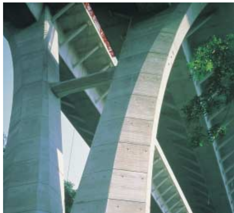
Viaduc de Rogerville.
