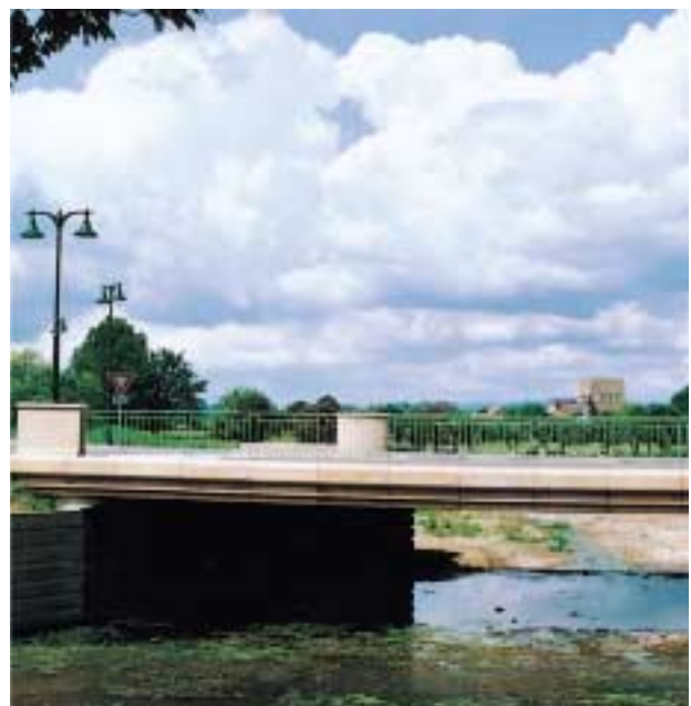
Pont de décharge de l'Arroux.
