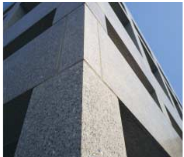
L'apparence découle à la fois du choix des composants du béton et du traitement de surface.
