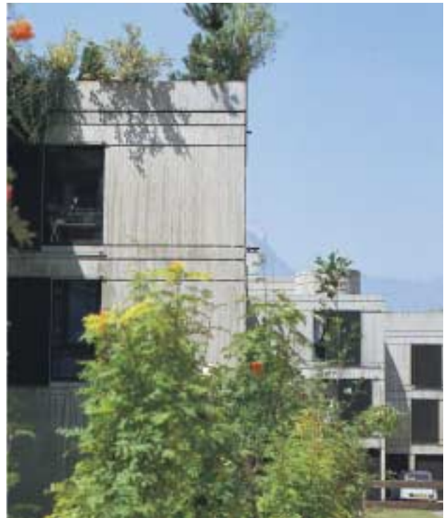
Béton brut de décoffrage.
